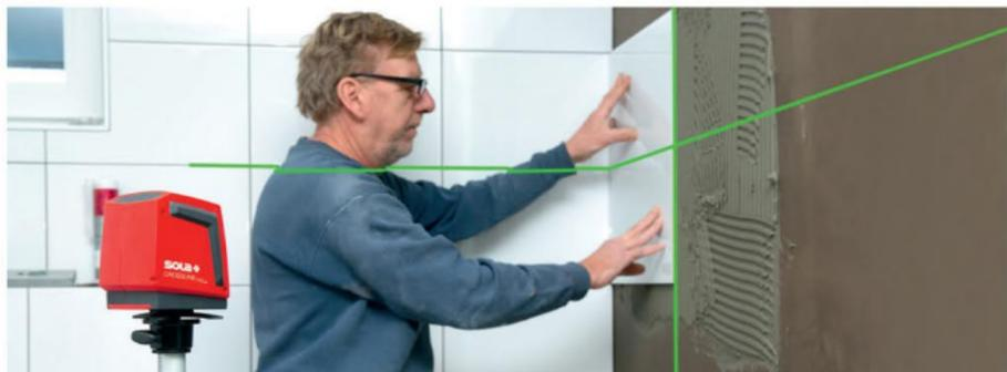
O linie laser orizontală și o linie laser verticală extrem de vizibile formează o cruce în unghi de exact 90°.
